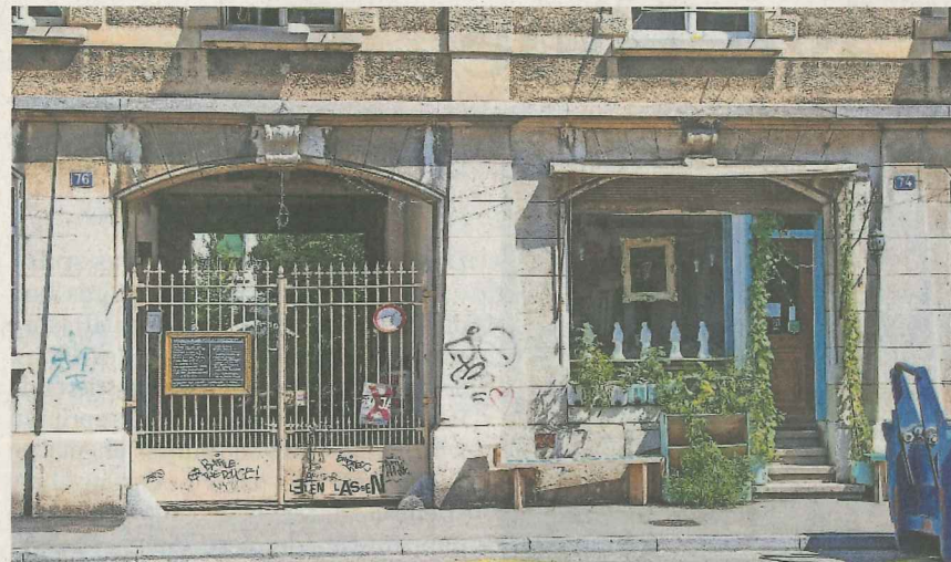
Eigentlich wollte der Besitzer hier einen Neubau realisieren.
